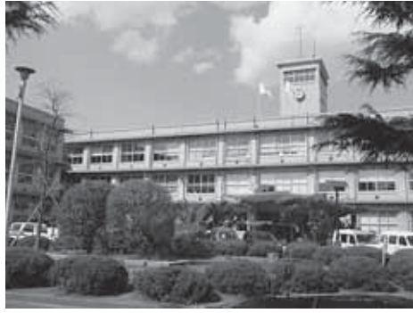
昭和29年に建築され、老朽化が進む市役所本庁舎。
